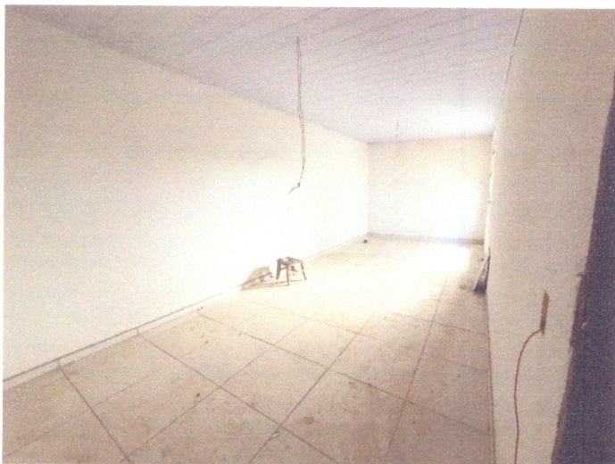
REVESTIMENTO CERÂMICO, PONTO DE TOMADA, PONTO DE INTERRUPTOR, PONTO DE LUZ
