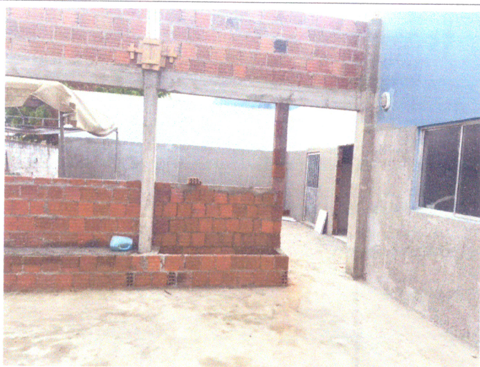
ALVENARIA, CONTRAPISO, CINTAS E VERGAS EM CONCRETO ARMADO
