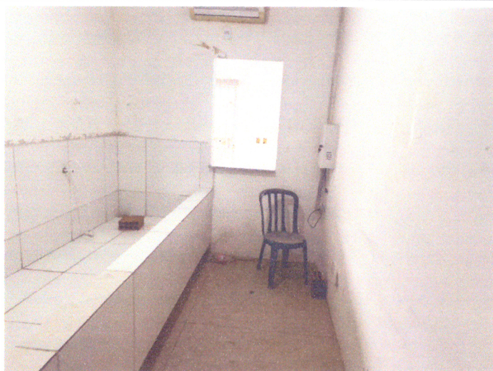
REVESTIMENTO CERÂMICO, PONTO DE TOMADA, PONTO DE INTERRUPTOR
