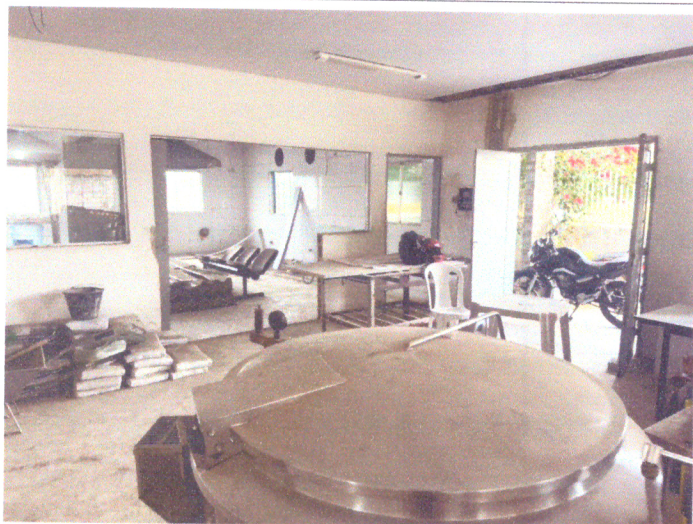
JANELA, REVESTIMENTO CERÂMICO
