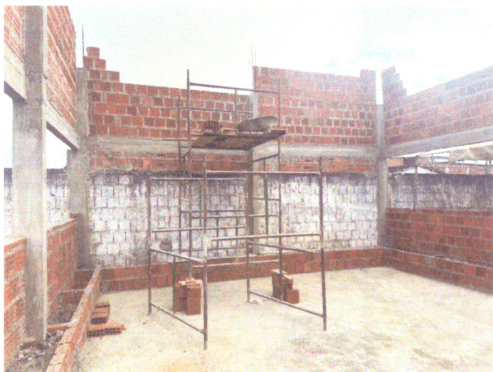
ALVENARIA, CONTRAPISO, CINTAS E VERGAS EM CONCRETO ARMADO
