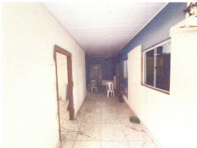
JANELA, REVESTIMENTO CERÂMICO, PONTO DE LUZ
