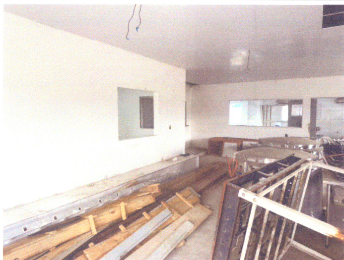
JANELA, REVESTIMENTO CERÂMICO, PONTO DE TOMADA, PONTO DE INTERRUPTOR, PONTO DE LUZ
